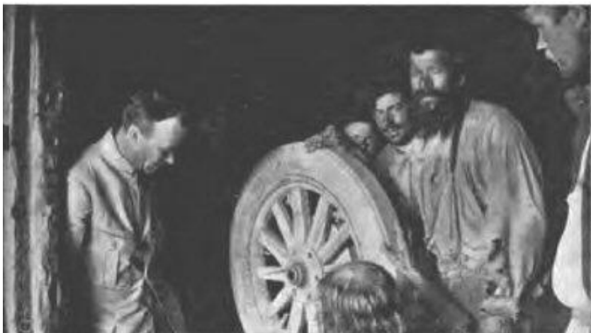
La ruota nuova fabbricata in sette ore da un fabbricante di teleghe e i suoi aiutanti in un villaggio russo tra Perm e Kazan. Fotografia presa nella fucina.
