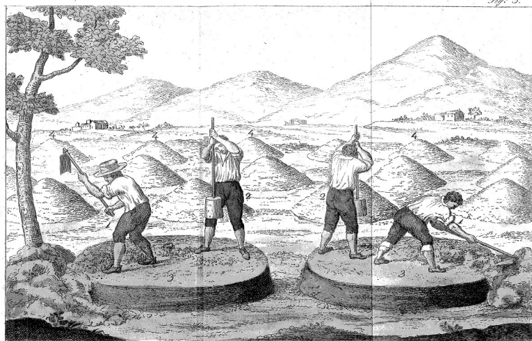
1. Uomo che con la Zappa esegue i mucchi della terra } 3. Mucchi di terra non ancora terminati 2. Uomo che con mazzaranga batte la terra a strati } 4. Mucchi di terra già fatti
