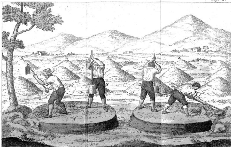
1. Uomo che con la Zappa asieua i mucchi della terra 2. Uomo che con mazzara batte la terra a strati 3. Mucchi di terra non ancora terminati 4. Mucchi di terra già fatti
