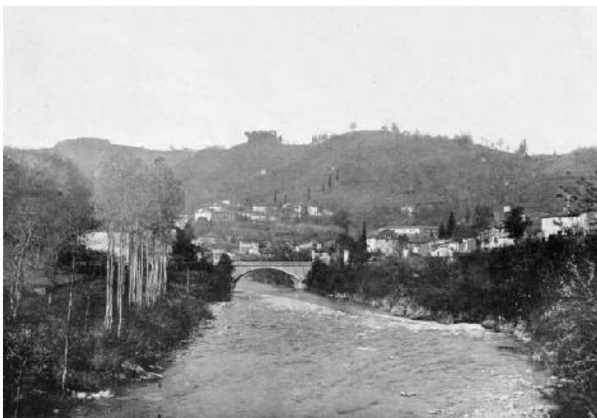
PONTE A MOCCO.
