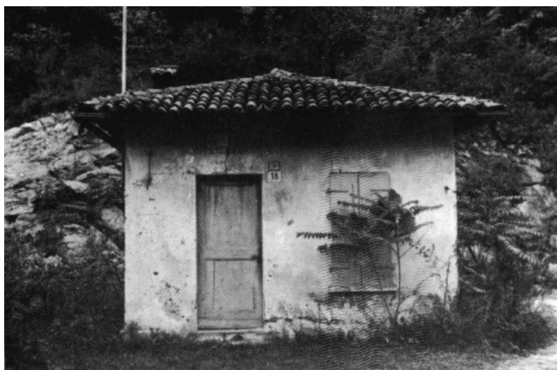
L'ufficio daziario all'ingresso di Varallo dalla parte
