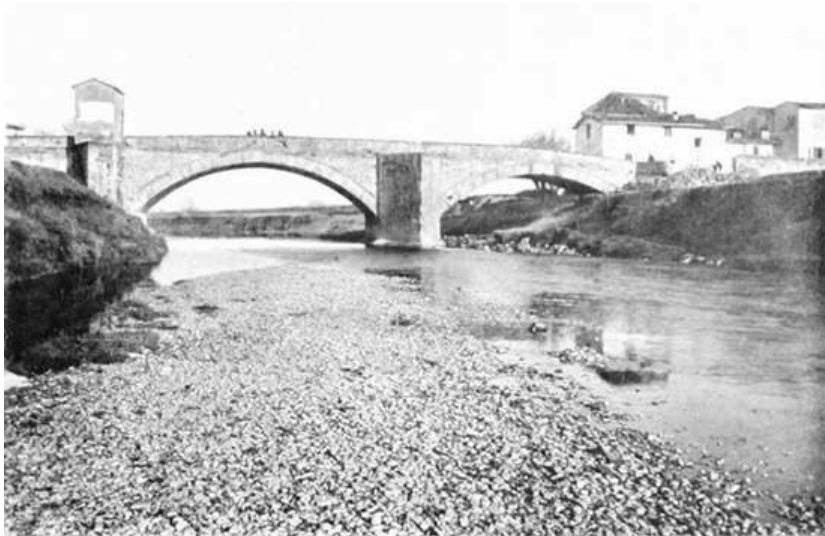
PONTE A GREVE LUNGO LA VIA PISANA.
