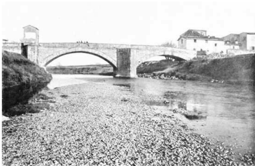
PONTE A GREVE LUNGO LA VIA PISANA.
