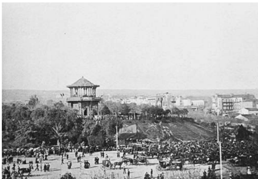
GIARDINO BELLINI — PIAZZALE. (Fot. Gentile).
