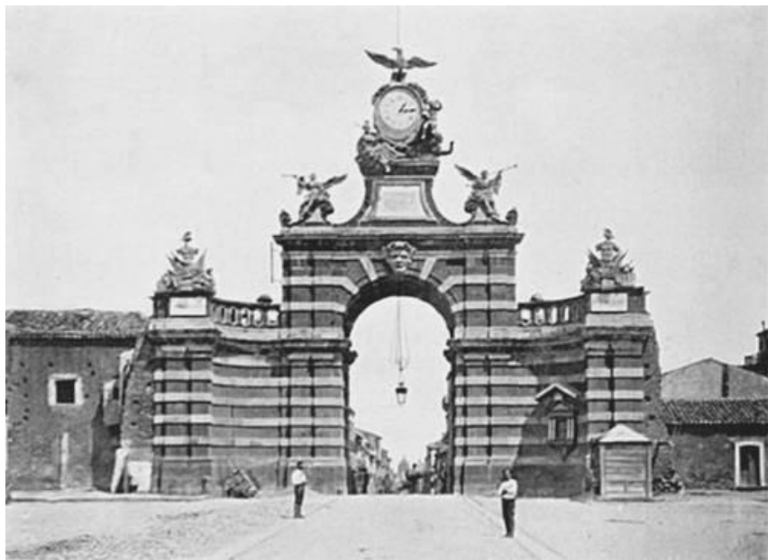
PORTA GARIBALDI. (Fot. Brogi).
