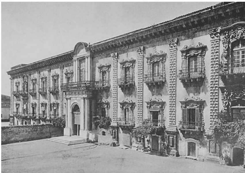
MONASTERO DEI BENEDETTINI — FACCIATA PRIN- CIPALE. (Fot. Brogi).
