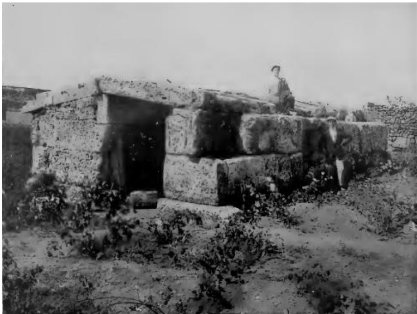
Fig. 106 – Edificio a grandi blocchi – PATÙ.
