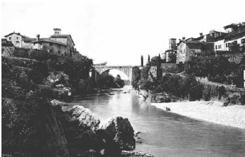
Cividale. Ponte del Diavolo, visto da nord.
