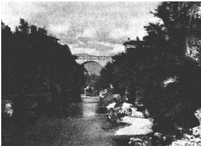
Fig. 18 a . — Lo storico ponte di S. Quirino.
